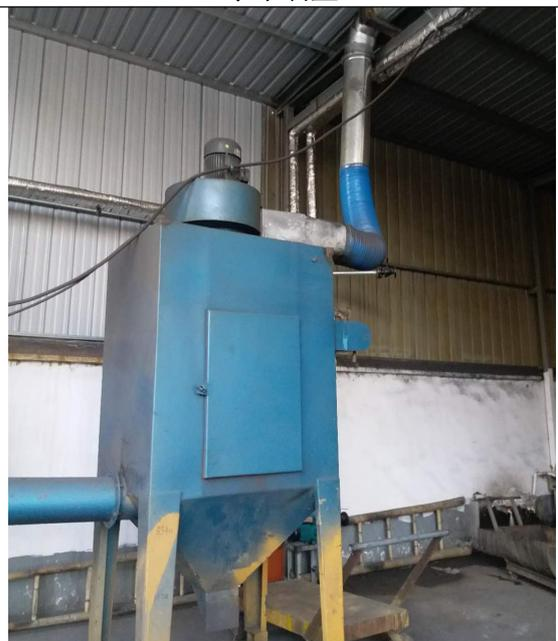
抛丸工序除尘器+15m 排气筒
